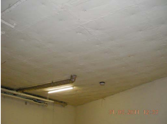
Decken - minimal gedämmt
