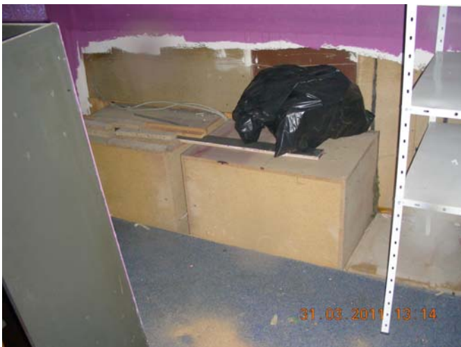
dahinter sind vermutlich Lüftungskanäle
