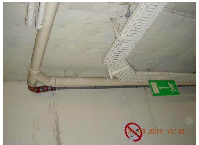
Leitungen unter Decke
