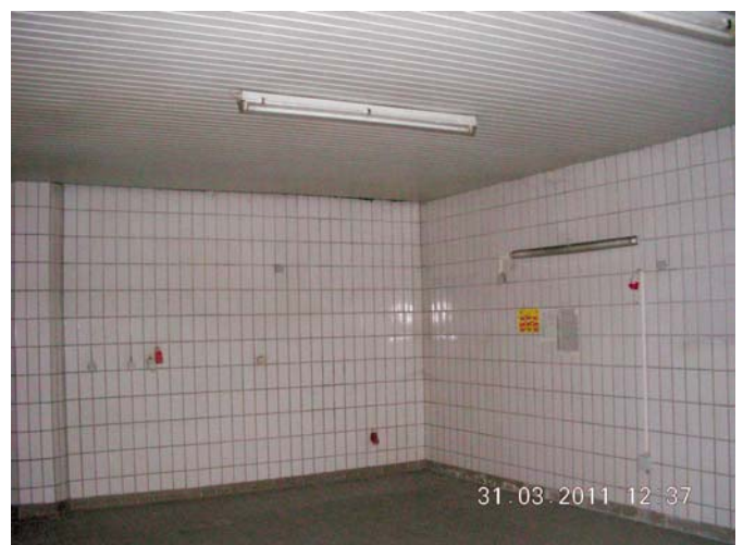
Ehemaliger Kühlraum / Fleischanlieferung Basement
