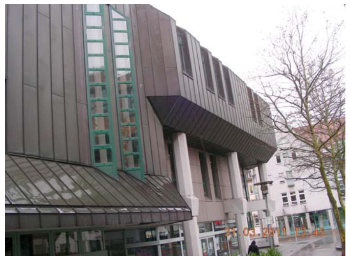
Kupferverkleidung / Fassade Blickrichtung Norden
