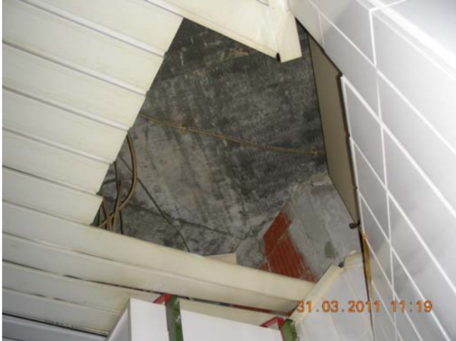
Decke Küchenbereich teilweise demontiert
