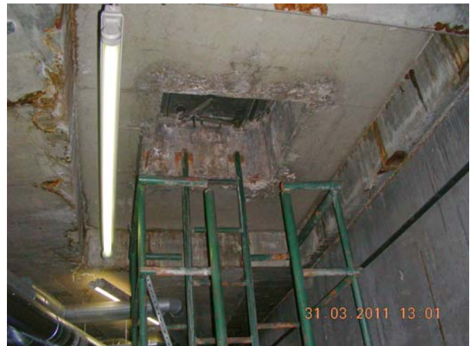
Ausstieg aus Heizraum
