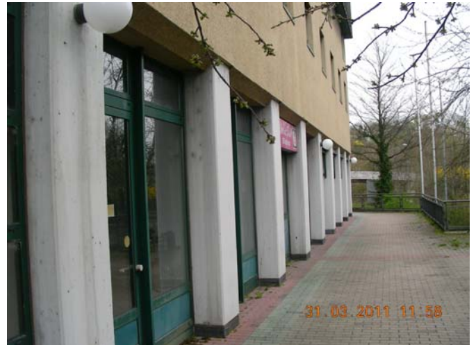
Ladenbereiche EG - Südwestseite
