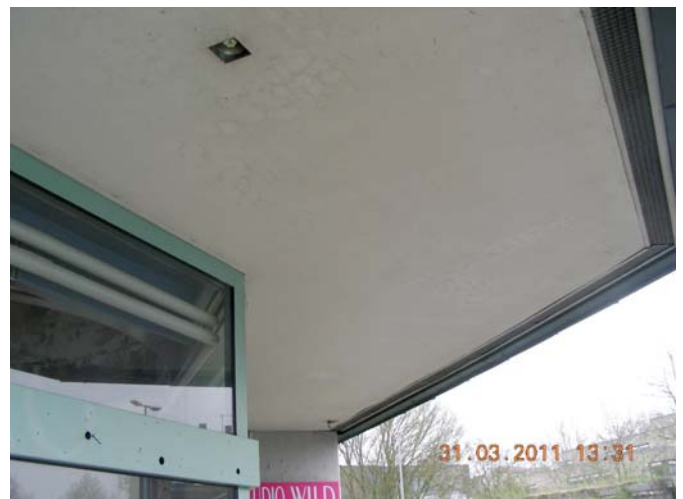
Decke Arkadenbereich Nordseite
