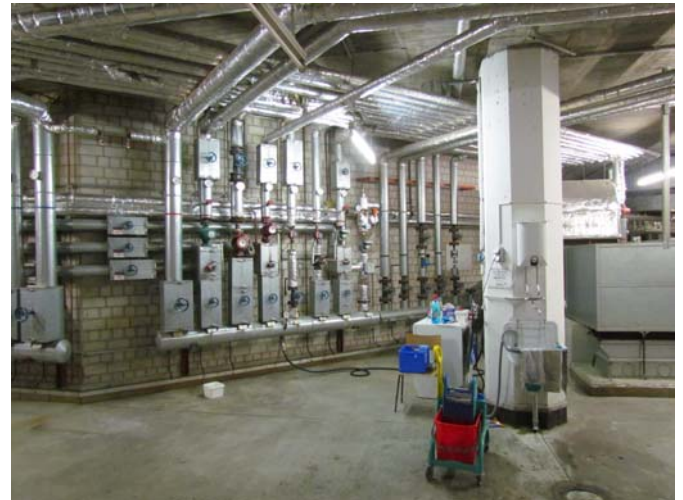
Heizungsverteiler Lüftungszentrale
