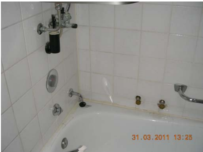
Bad leerstehende Wohnung
