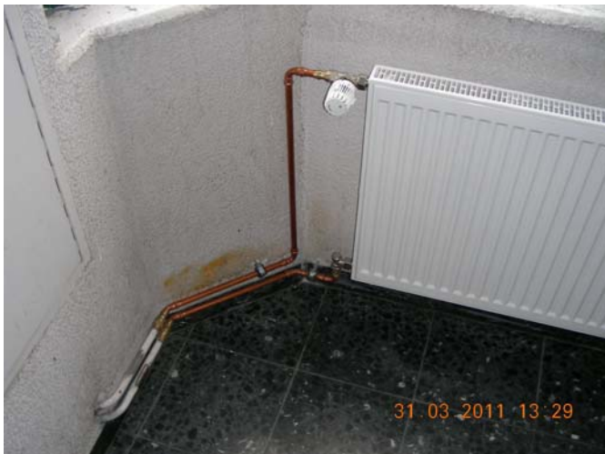
HK Flur - Rohre repariert
