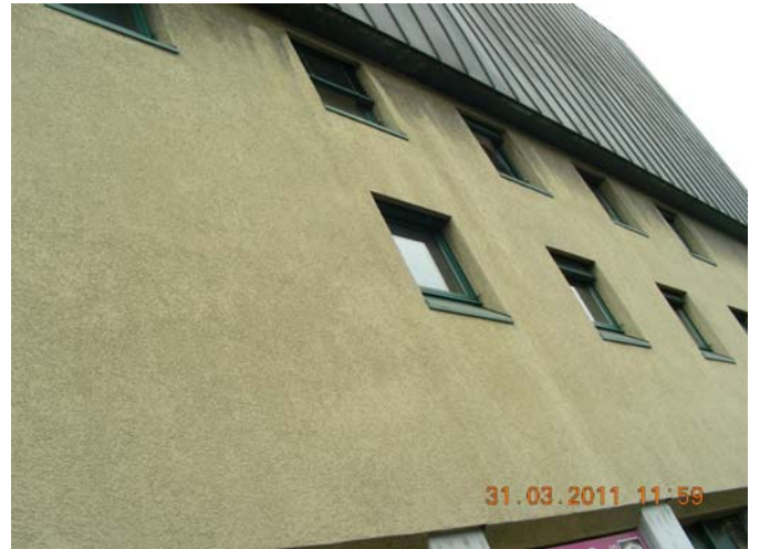
Putzfassade / Blechverkleidung Südwestfassade
