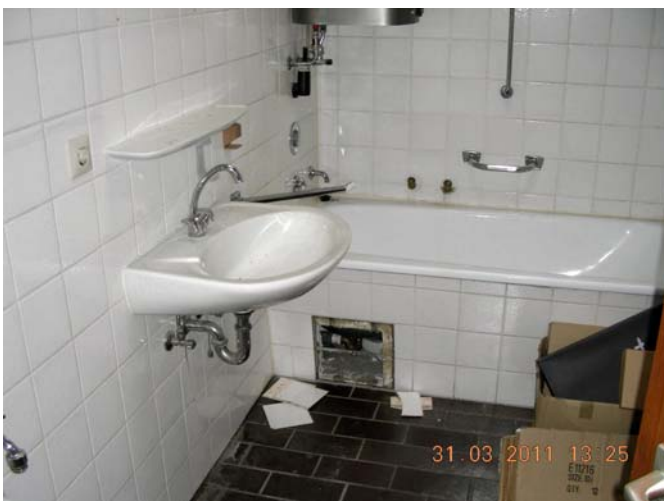
Bad leerstehende Wohnung
