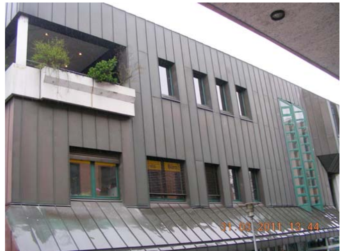
Blechverkleidung - leichte Dellen
