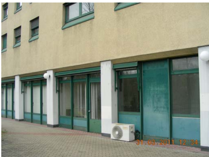
Fassadenansicht Gewerbe Ostseite
