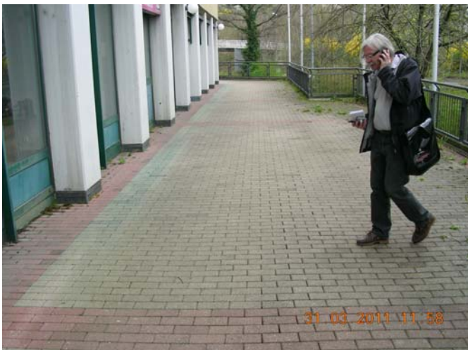
Ladenbereiche EG - Südwestseite
