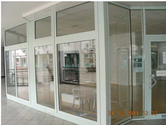
Läden leerstehend auf Nordseite
