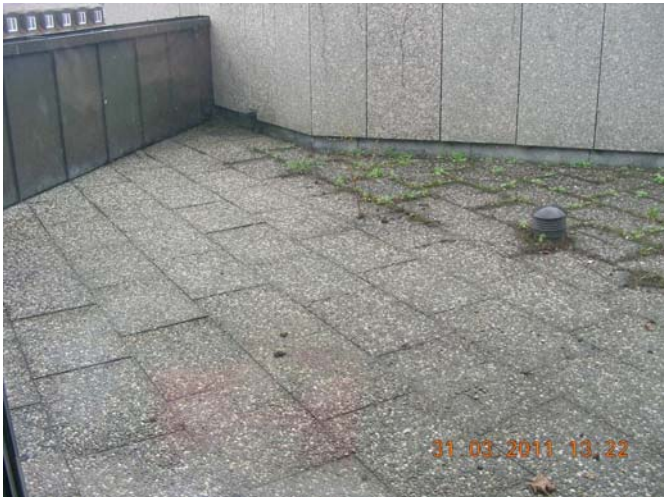
Dachterrassen vor Wohnungen im 3.OG
