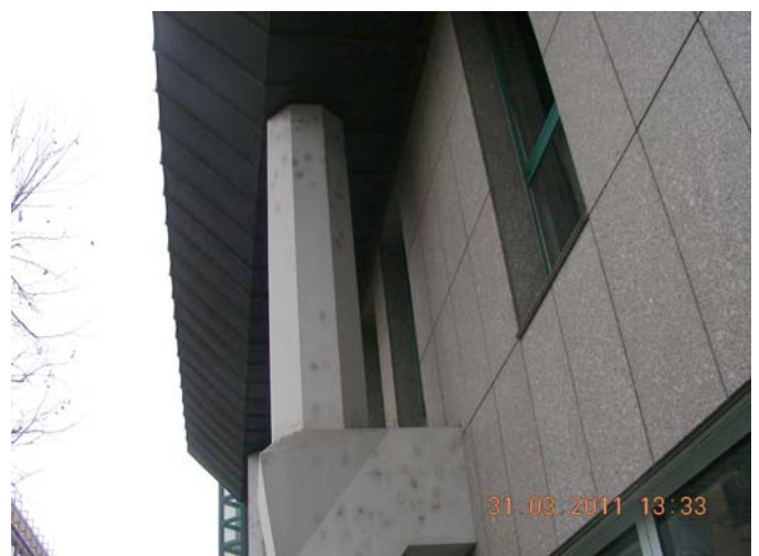
Aussenstützen ungedämmt
